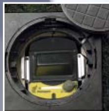
XiLog installé dans un regard compteur Atlas
